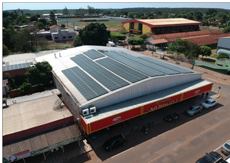
Figura 2.21 - Módulos Fotovoltaicos instalados nas áreas nordeste e sudoeste
