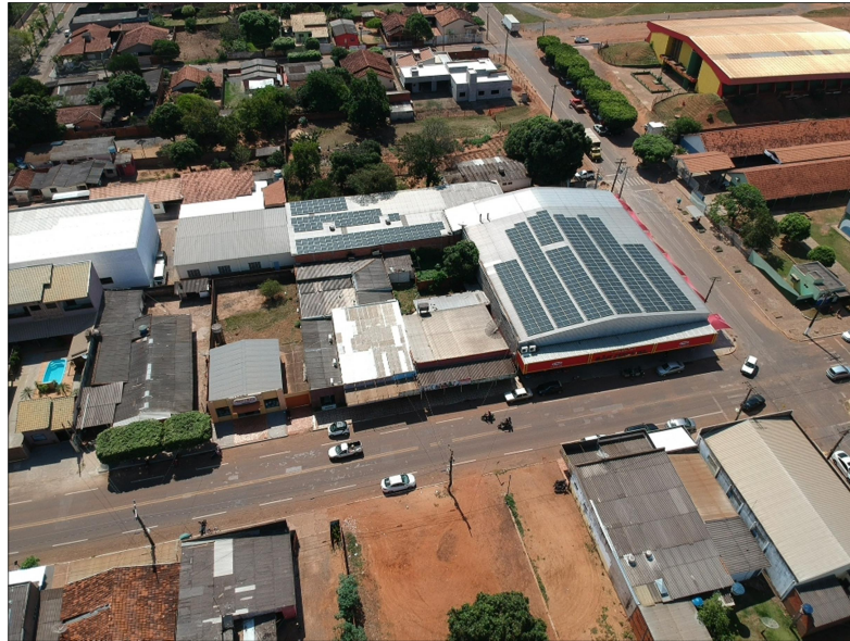
Figura 2.20 - Visão geral dos módulos instalados no supermercado
