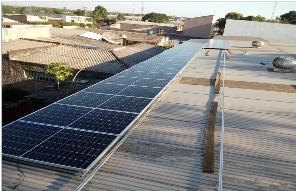
Figura 2.23 - Sombreamento de uma string na área sudeste
