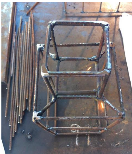
Figura 36 – Etapa de soldagem da estrutura.
