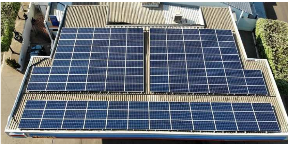
Figura 28 - Instalação do sistema fotovoltaico, sendo utilizado 12 strings com 11 módulos em série para cada string.
