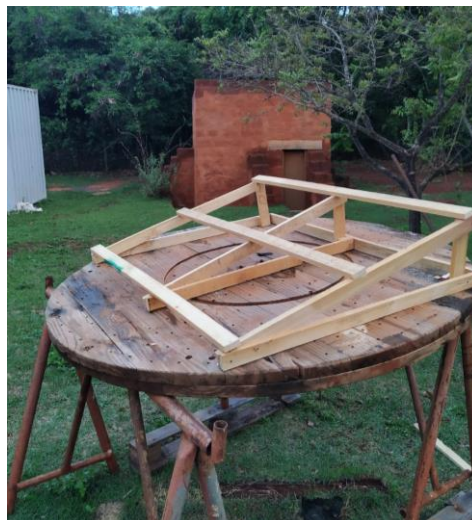
Figura 4.25 Estrutura de sustentação desenvolvida em madeira
